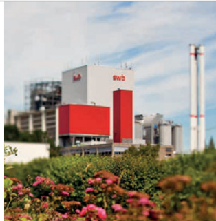
Müllheizkraftwerk Bremen (MHWK)
